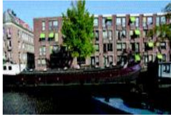
Rietvinck voor de verbouwing
